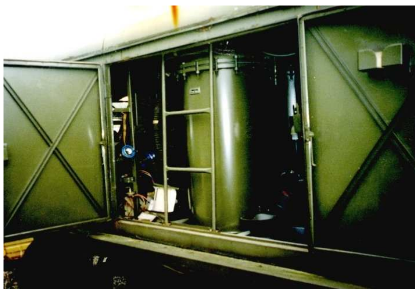
Úpravna vody ÚV 2000 s elektrocentrálou
